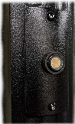
Button Photocell On Door (PCD)
