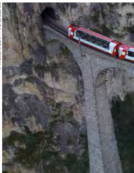
GLACIER-EXPRESS auf dem Landwasserviadukt
