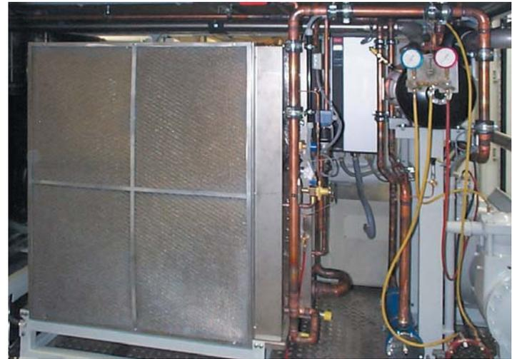
Um die global stark unterschiedlichen Außentemperaturbedingungen am Einsatzort zu berücksichtigen, wurden zwei verschiedene TRACU-Varianten entwickelt. Die Standardvariante ist ausgelegt bis zu Außenbedingungen von +40 °C/40 % relativer Feuchte, die Tropen- und Wüstenausführung bis zu einer Außentemperatur von +55 °C/40 % relativer Feuchte.
