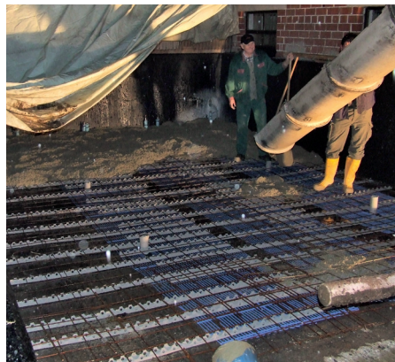
Betonieren des Pferdemisthaufens
