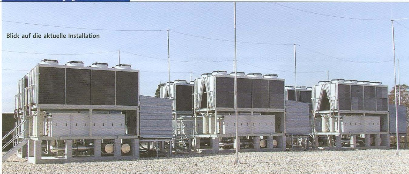
10 000 kW Kältebedarf für 160 000 Internetrechner
