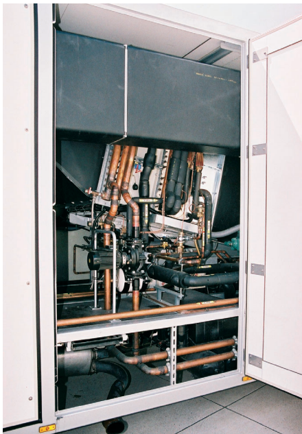
Die Kältetechnik im Inneren der TRACU musste unter äußerst beengten Platzverhältnissen installiert werden
