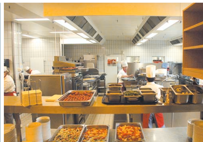
Alle Räume mit stark wechselnder Belegung, also Restaurants, Konferenzräume und Küchen, sind mit Luftqualitätsregelungen ausgestattet
