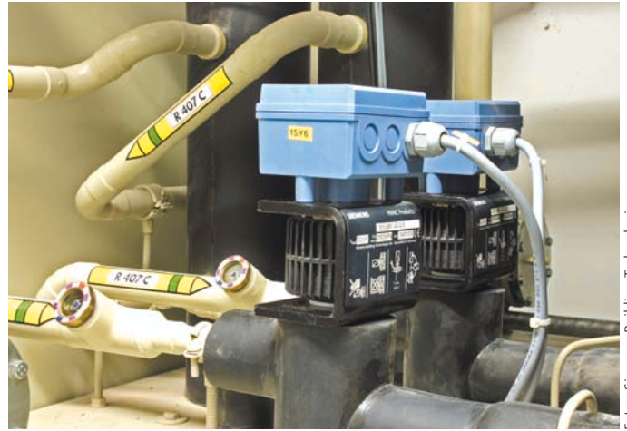
Zu den hohen Heizzahlen der Wärmepumpe von bis zu 6 trägt auch das elektronische Expansionsventil Polycool von Siemens Building Technologies bei
