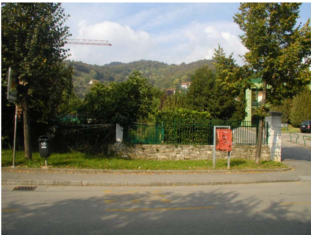
Veduta d'insieme del bacino del corso d'acqua BG024.48 dalla sezione di chiusura
