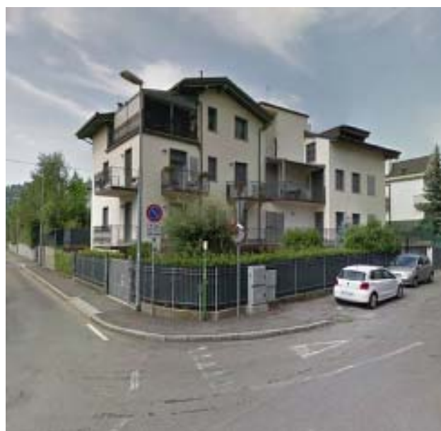
Vista fotografica (fonte: Google Street View)
