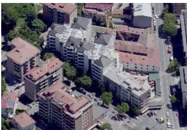
Vista fotografica (fonte: Geobly)
