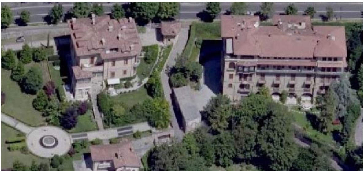
Vista fotografica (fonte: Geobly)
