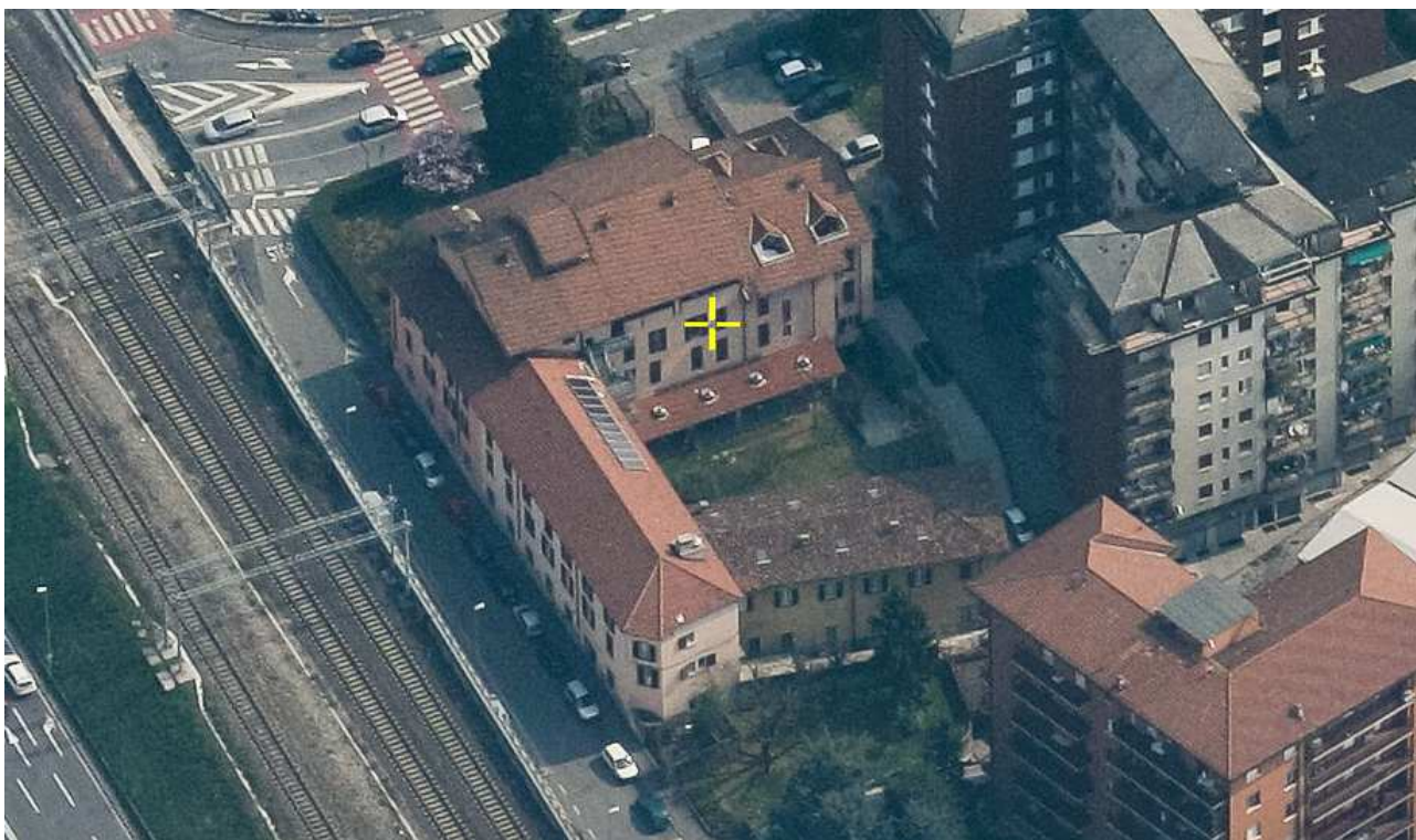
Vista aerea del fabbricato principale e delle relative pertinenze
