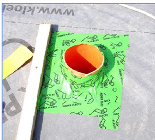
**Figura 50: bonifica edilizia esistente**Sigillatura delle tubazioni impiantistiche e del nodo solaio-parete.
