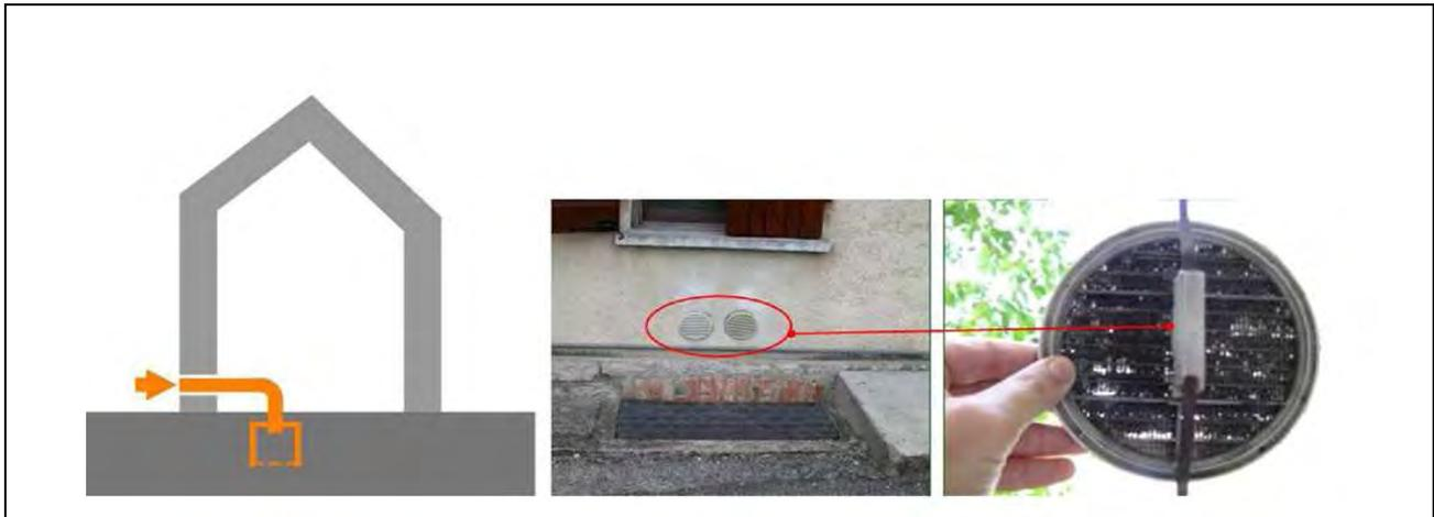
Figura 20: è necessario mantenere puliti i punti di aspirazione
