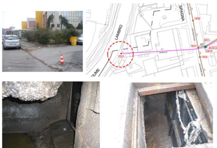
Figura 13 - Manufatto sfioratore, canale n.1851.
