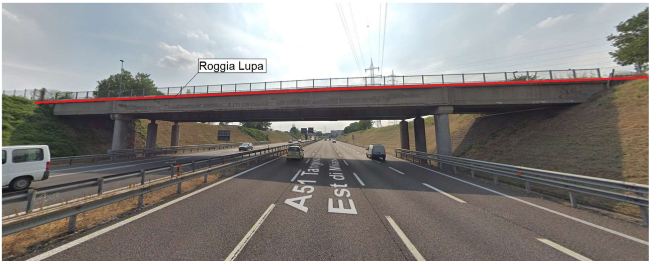
Figura 5 - Attraversamento Roggia Lupa su tangenziale A51 con ponte tubo.
