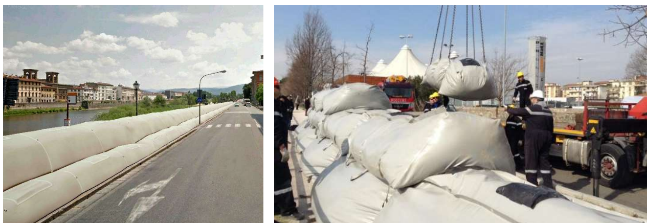
Figura 28 – Esempi di allestimento di arginature rimovibili gonfiabili o modulari con riempimento in sabbia.
