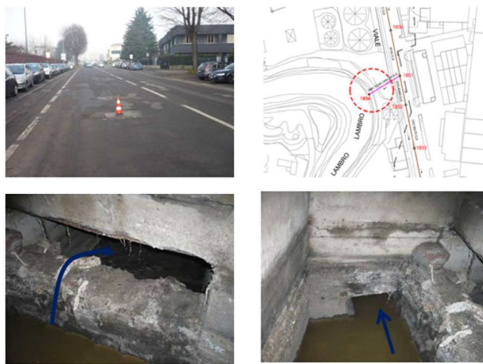
Figura 12 - Manufatto sfioratore, camera n.1851.
