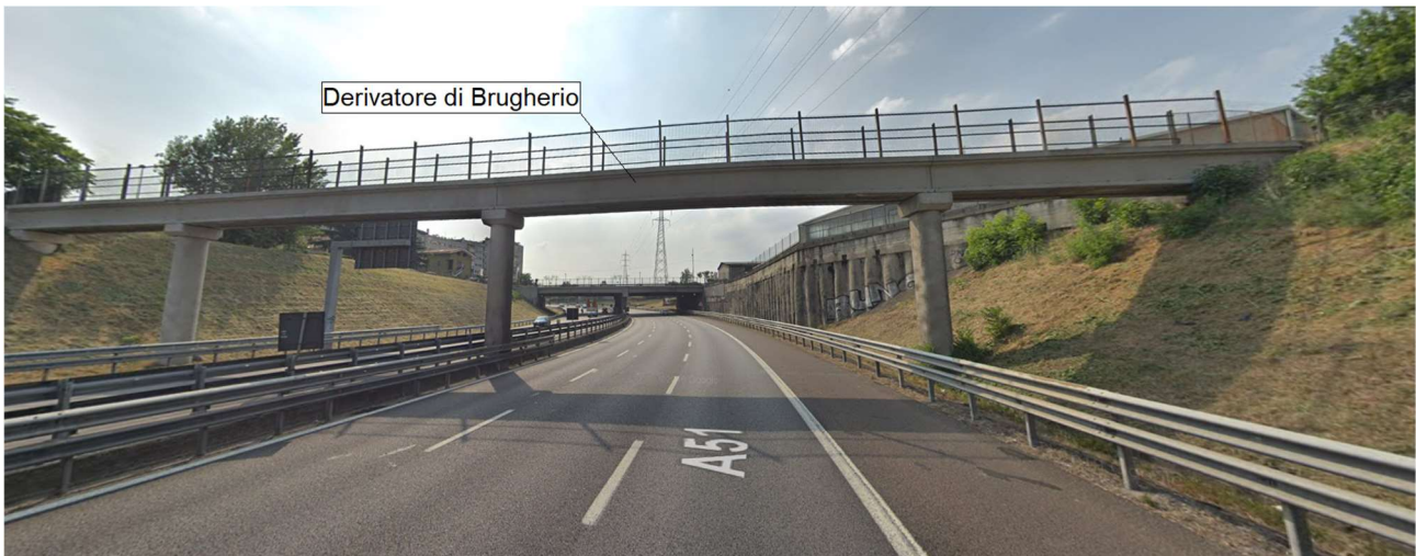
Figura 7 - Ponte canale di attraversamento del Derivatore di Brugherio sulla tangenziale A51.
