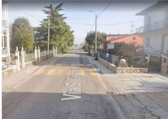
Vista della fermata del TPL lungo Via San Giovanni, lato Est
