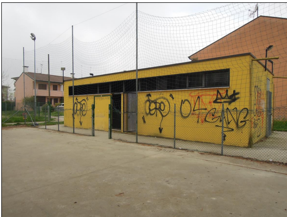
3-4- Viste del campo e spogliatoi
