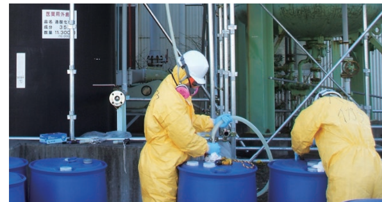
■ 薬液タンクからの高濃度薬品（過酸化水素 35%）の抜き取り作業と処理
