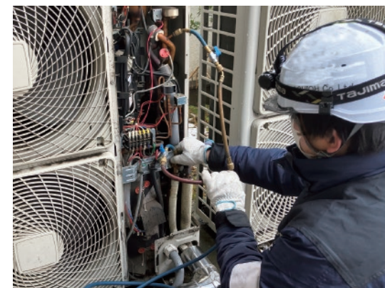
■ フロンガスの回収作業
