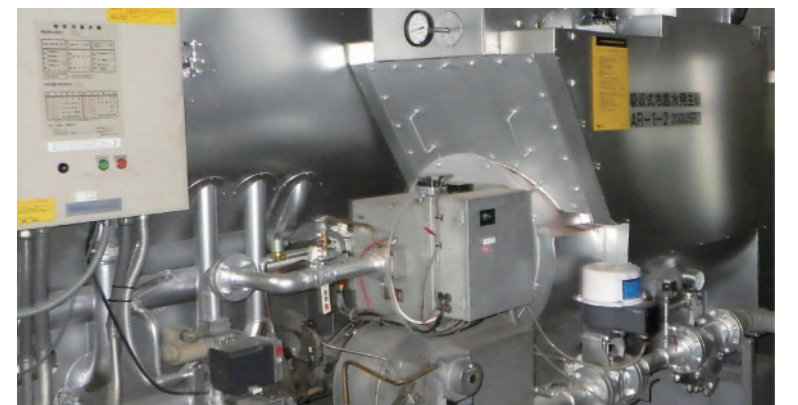
■ 吸収式冷凍機内部の臭化リチウム溶液の抜き取り作業と処理
