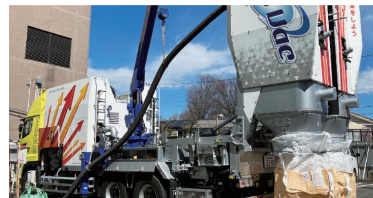
■ 清掃工場の解体工事に伴い、活性炭サイロからの活性炭の抜き取りと廃棄作業
