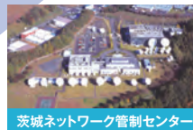
茨城ネットワーク管制センター
