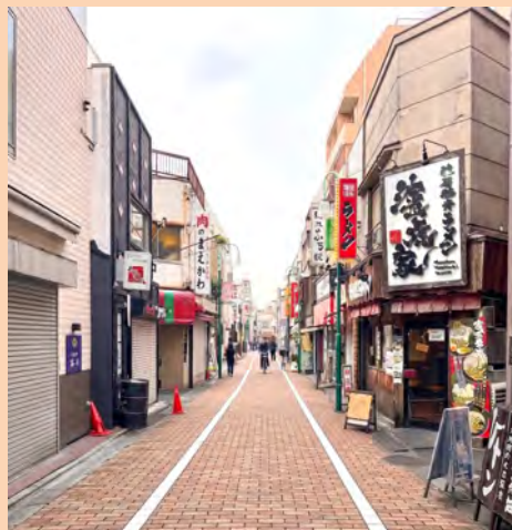
電信柱撤去 ～路面舗装
