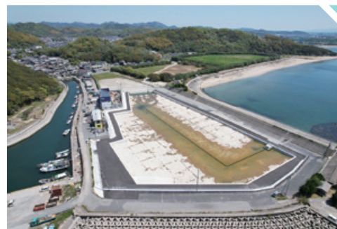
▲ 福泊調整池設置工事
