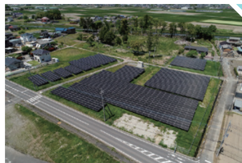
▲ サンテックパワージャパン行田太陽光発電所5 設置工事
