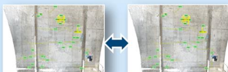
貸与された発注図書の補修箇所・数量と 現在の対象構造物の状態を比較し、差分を自動算出
