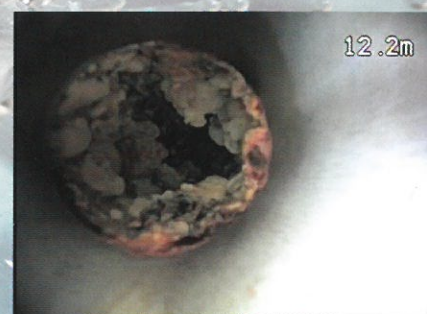
【無ライニングの異形管部に錆瘤による閉塞】
