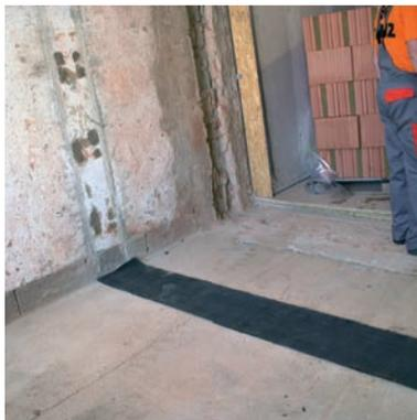
① Na podlahu se položí těžký asfaltový pás tl. min. 3,5 mm. Pás je širší než budoucí stěna o min. 50 mm na každou stranu od líce neomítnuté budoucí stěny proto, aby nedošlo k propojení omítky s podlahou.
