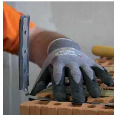
③a Je třeba počítat, že do každé druhé ložné spáry se použijí 2 nerezové kotvy podlepené pěnovou PE páskou pro připevnění ke stávajícím stěnám.
