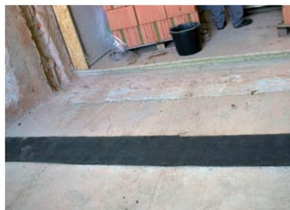
Vždy založit na těžký asfaltový pás min. tloušťky 3,5 mm
