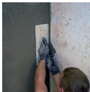
⑫ V ostění i v rovině stěny se čerstvá omítka prořízne zednickou lžící, špachtlí, nožem až na minerální vlnu či PU pěnu. Vznikne spára tl. cca 3-5 mm.
