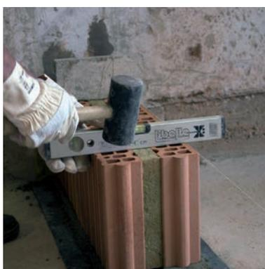
⑤ Založí se první řada cihel do přeřezaného maltového lože. **Cihelné bloky HELUZ AKU KOMPAKT 21 broušená se při zdění uchopují oboustranně (jedna ruka na jednu tvarovku).**
