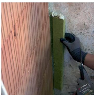
⑩ Stěna se omítne. Před omítáním se odstraní přesahující materiály (ořeže se minerální vlna v ostění a PU pěna v koruně stěny).
