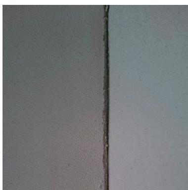
⑬ Postup začištění přípojovací spáry akrylovým tmelem.
