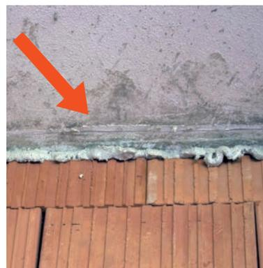
⑨ Mezera mezi stropní konstrukcí a korunou stěny se celá vyplní pěnou Tytan B1 (černo-černá kartuše). Tloušťka spáry může být max. 20 mm.
