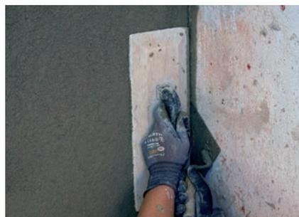
V ostění se čerstvá omítka prořízne zednickou lžící, špachtlí, nožem až na minerální vlnu, podobně u stropu. Vznikne spára tl. cca 3-5 mm. Vzniklá spára se vyplní systémovým akrylovým tmelem!
