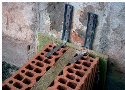
Je třeba počítat, že do každé druhé ložné spáry se použijí 2 nerezové kotvy pro připevnění ke stávajícím stěnám.
