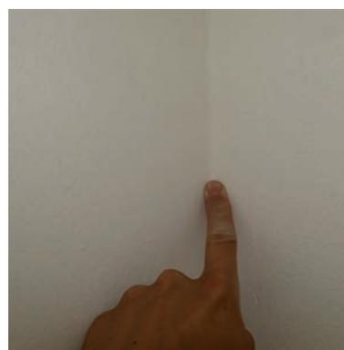
⑭ výsledný povrch přípojovací spáry na vymalované stěně.
