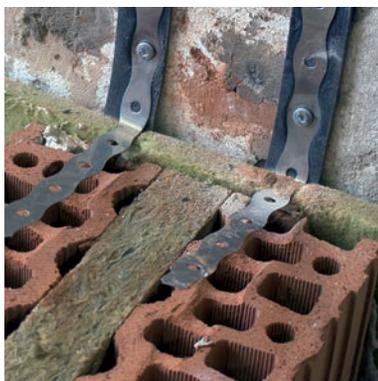
③b Při vkládání kotev do ložné spáry je třeba cihelné tvarovky mírně zbrusit – vytvořit drážku pro kotvu – aby nedošlo k rozevření ložné spáry.
