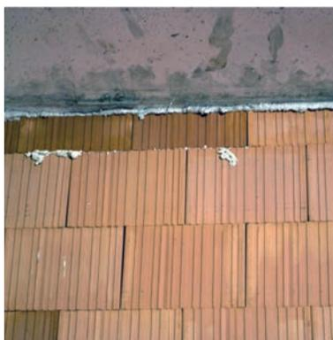
⑧ Stěna se dozdí až po stropní konstrukci.
