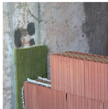
④ Na ostění stávajících stěn se připevní minerální vlna tl. 20 mm a šířky cca 22 cm. Připevní se např. pomocí dodané PU pěny HELUZ.
