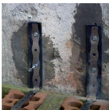
③c Kotva se ke stávající stěně připevní pomocí hmoždinky (natloukáč či univerzální např. UX) popř. samořezným šroubem.
