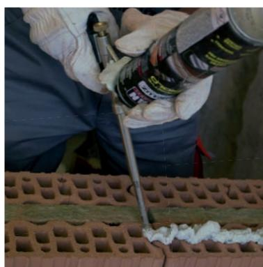
⑥ Pokračuje se zděním pomocí HELUZ pěny (černá kartuše). Nanáší se celkem dva pruhy pěny. **Přířezy a malé mezery ve styčných spárách se vyplňují PU pěnou, ale pouze na šířku jedné cihelné tvarovky, nikoliv přes celou tloušťku stěny!** Maximální mezera mezi přířezem a vatou na ostění stávající konstrukce je max. 10 mm.
