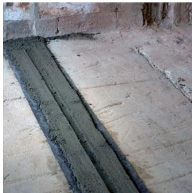
② Na asfaltový pás se nanese základací malta ve dvou pruzích cca 9 cm širokých. Mezi pruhy je mezera cca 3-4 cm, která odpovídá tloušťce minerální vlny v cihelných blocích HELUZ AKU KOMPAKT 21 broušená.
