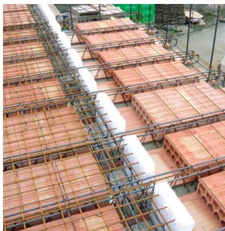
Konzola balkónu - vázaná výztuž před betonáží
