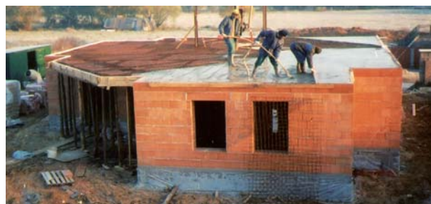
Položení stropu Porotherm
