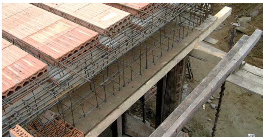
Rohové okno bez sloupku před betonáží
