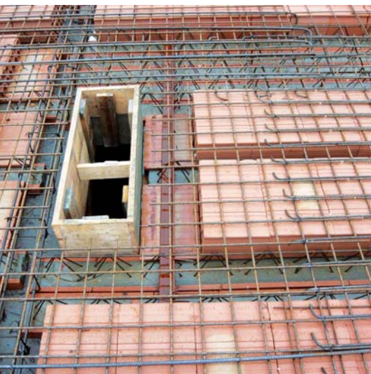
Komínová výměna pomocí úhelníku L 75/50/6
