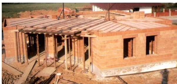
Položení stropu Porotherm
