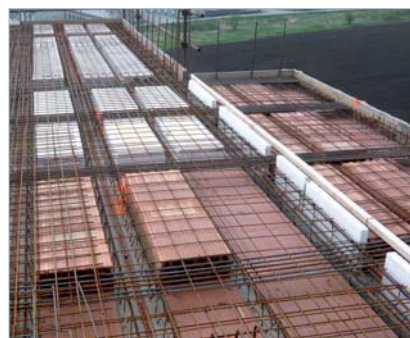
přerušení tepelného mostu mezi balkónem a stropem
