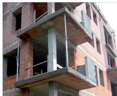
rohový balkón s přidanou výztuží
