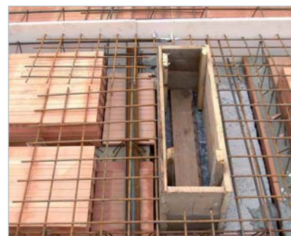
výměna u prostupu stropem pomocí vloženého úhelníku 75/50/6
