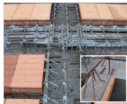
uložení trámečků do železobetonového průvlastku
