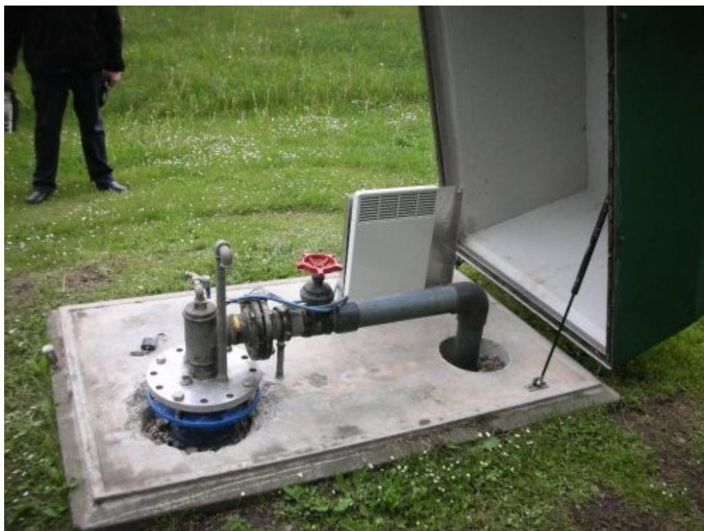
En indvindingsboring i en råvandsstation
