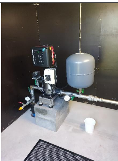
Billede 41-42 Viser trykforøgersektion
