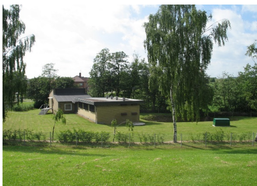
Figur 1 Eksisterende vandværk Skolevej -
