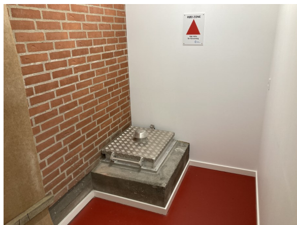
Nedgang til rentvandstank - nu indendørs, hvilket er en fordel i forhold til før.
