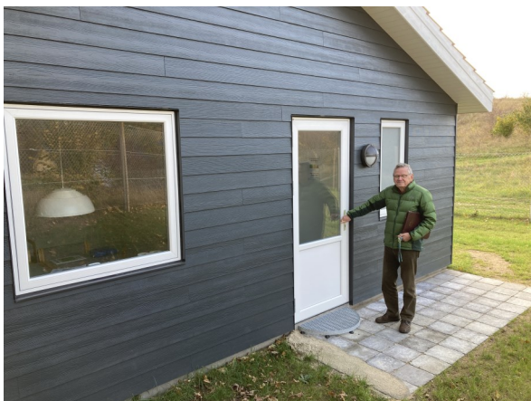
Indgang til vandværket foregår fremover via den nye tilbygning.
