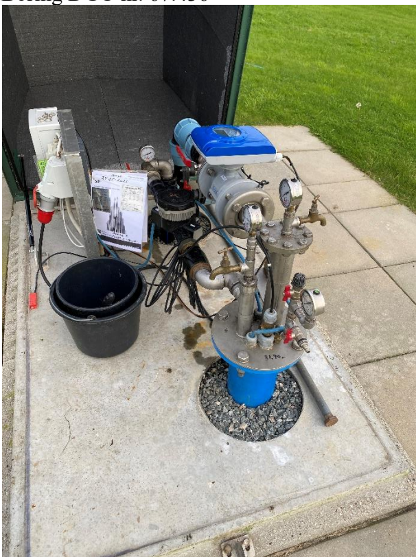
Boring DGU nr. 67.436
