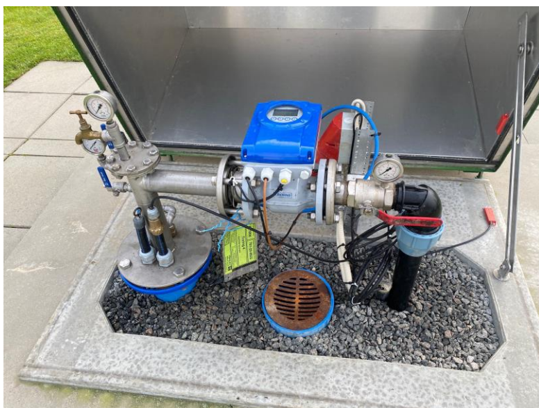
Boring DGU nr. 67.1006
