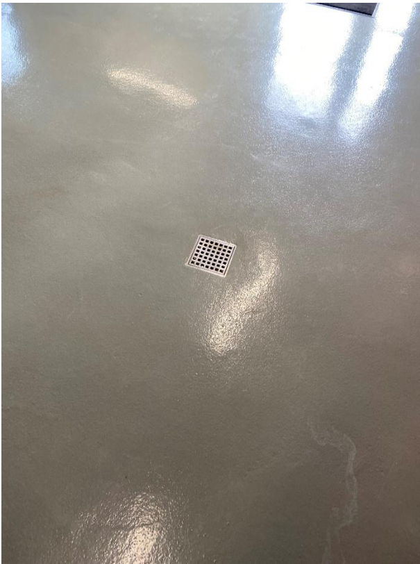
Gulvafløb går ned gennem rentvandstanken
