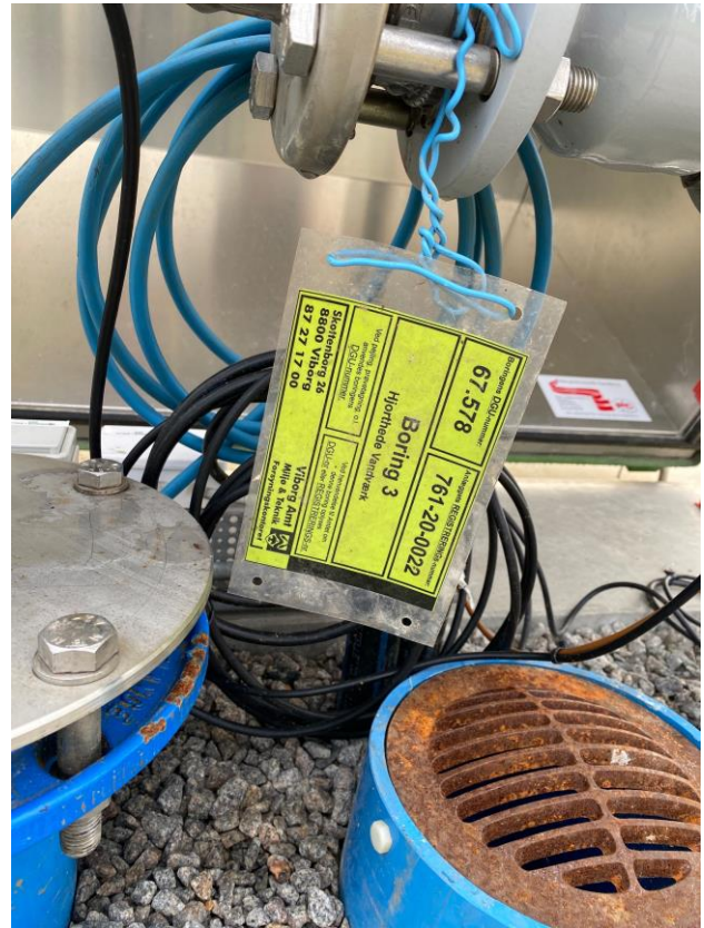
Boring DGU nr. 67.578
