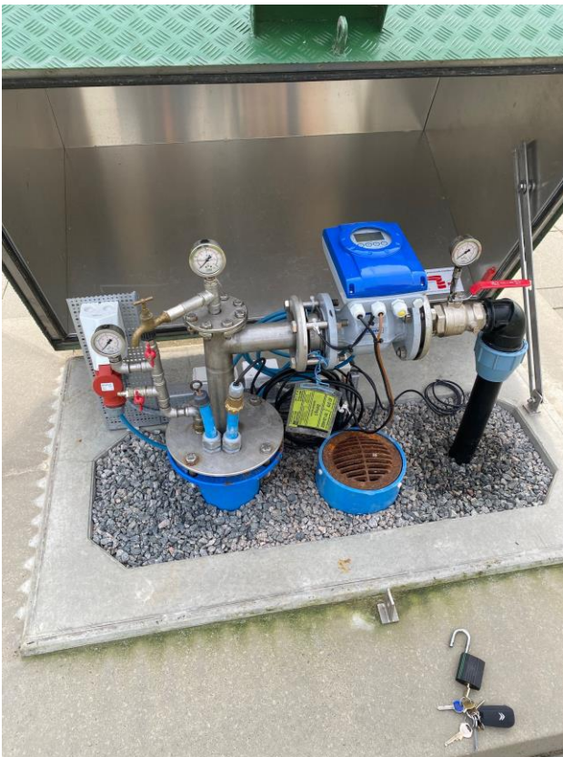
Boring DGU nr. 67.578
