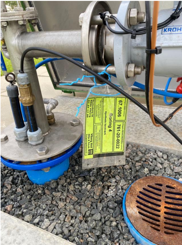
Boring DGU nr. 67.1006
