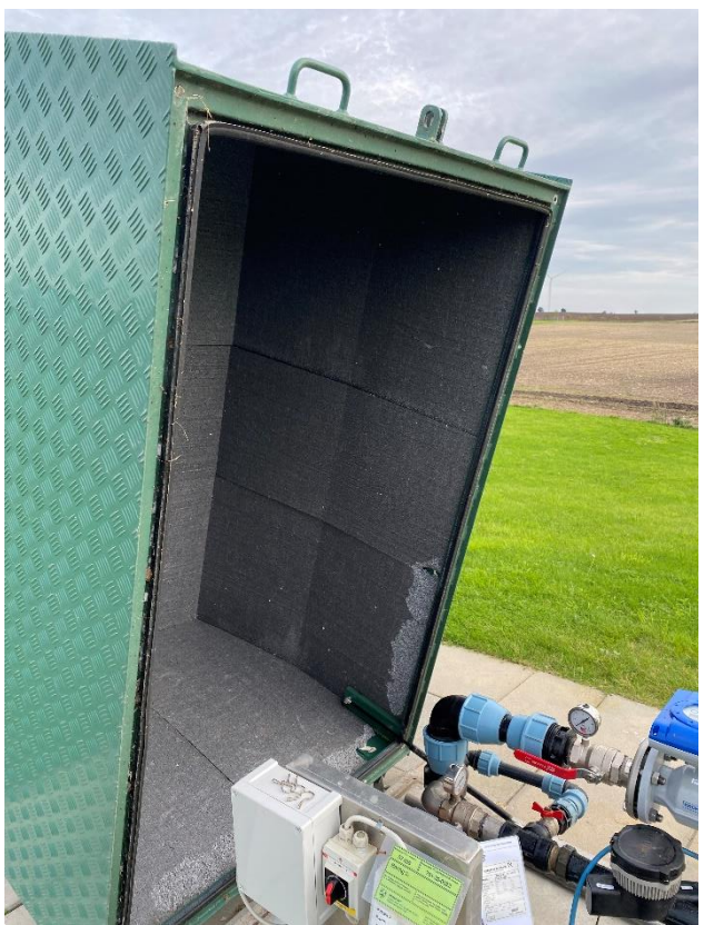
Boring DGU nr. 67.436
