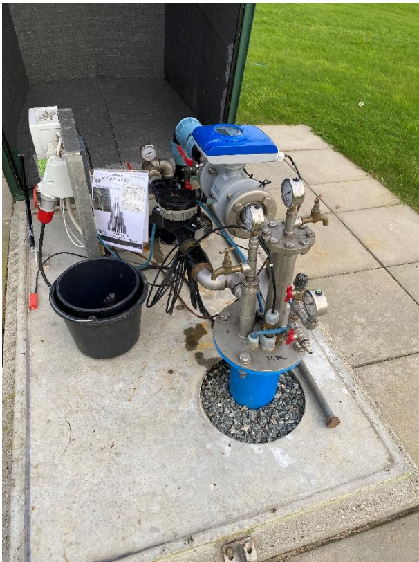
Boring DGU nr. 67.436
