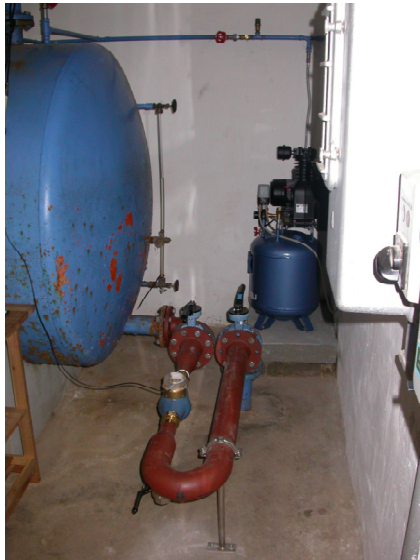
Vi har fået installeret afgangsmåler og en ny kompressor til hydroforen
