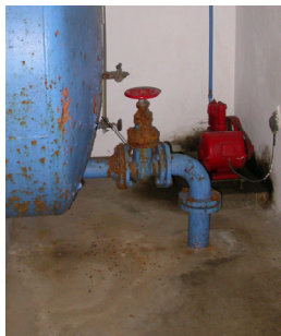
Vi har fået installeret afgangsmåler og en ny kompressor til hydroforen
