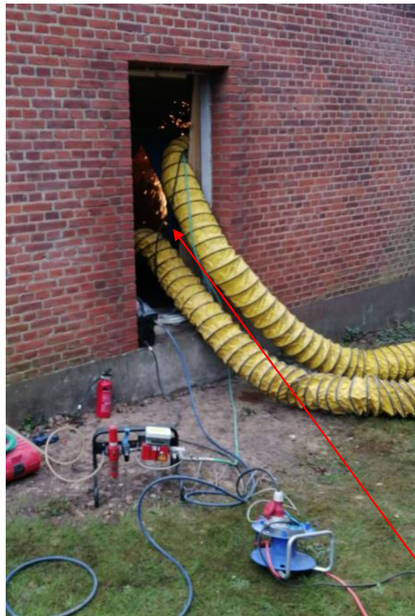
Plasmaskæring af hydrofor
