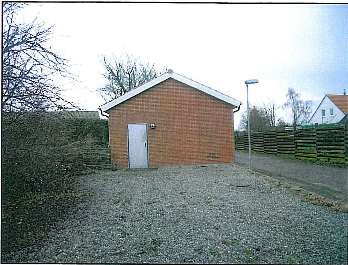
Fig. 3: Vandværket på Kongensgade 35 A.
