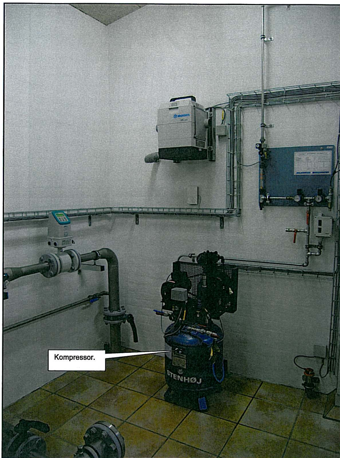
Fig. 12: Kompressor.
