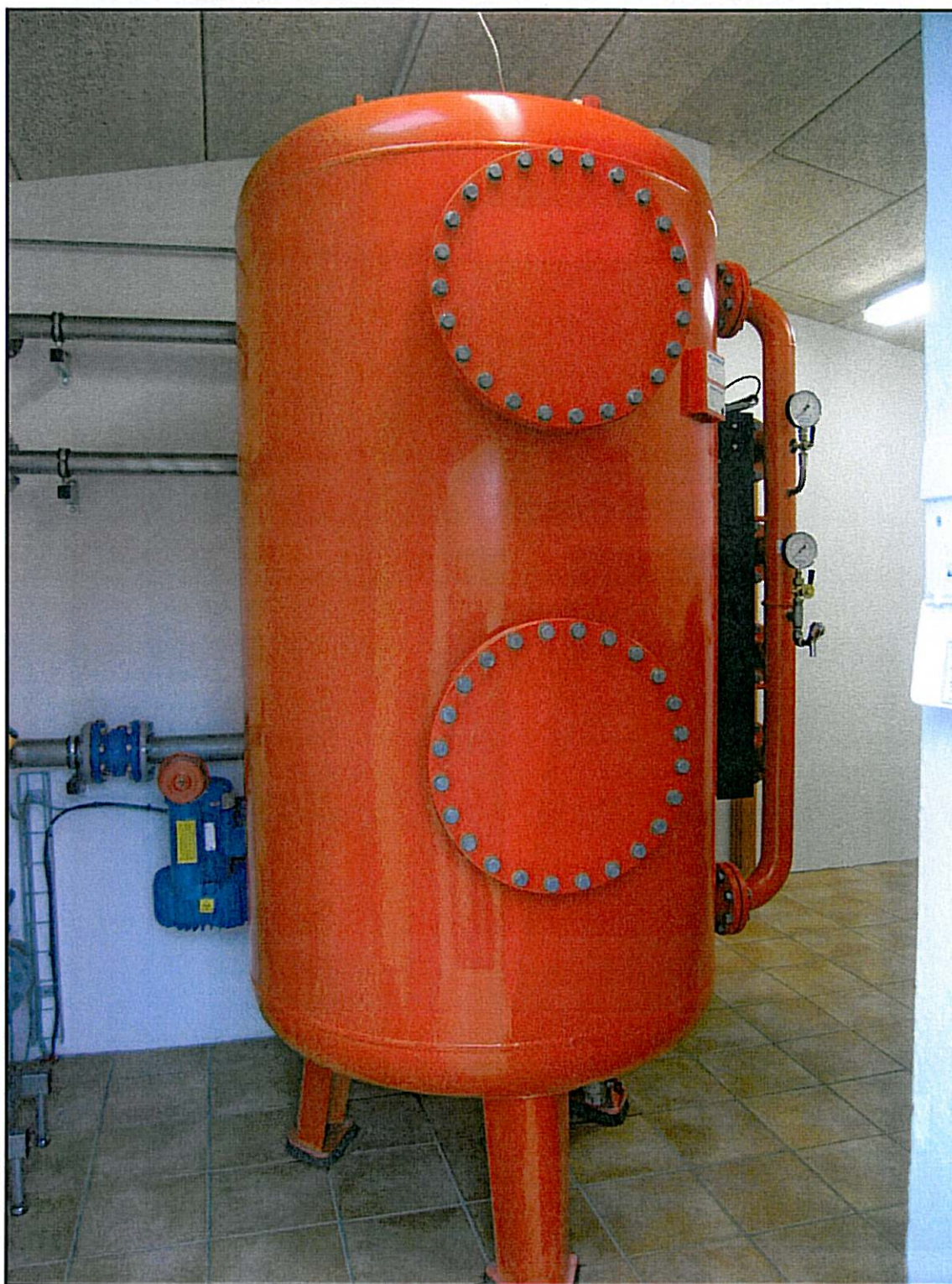
Fig. 8: Vandværkets filter.
