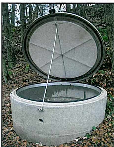
Fig. 25: Boring med dæksel.
