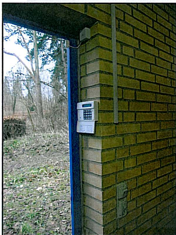
Fig. 14: Alarm til vandværket.
