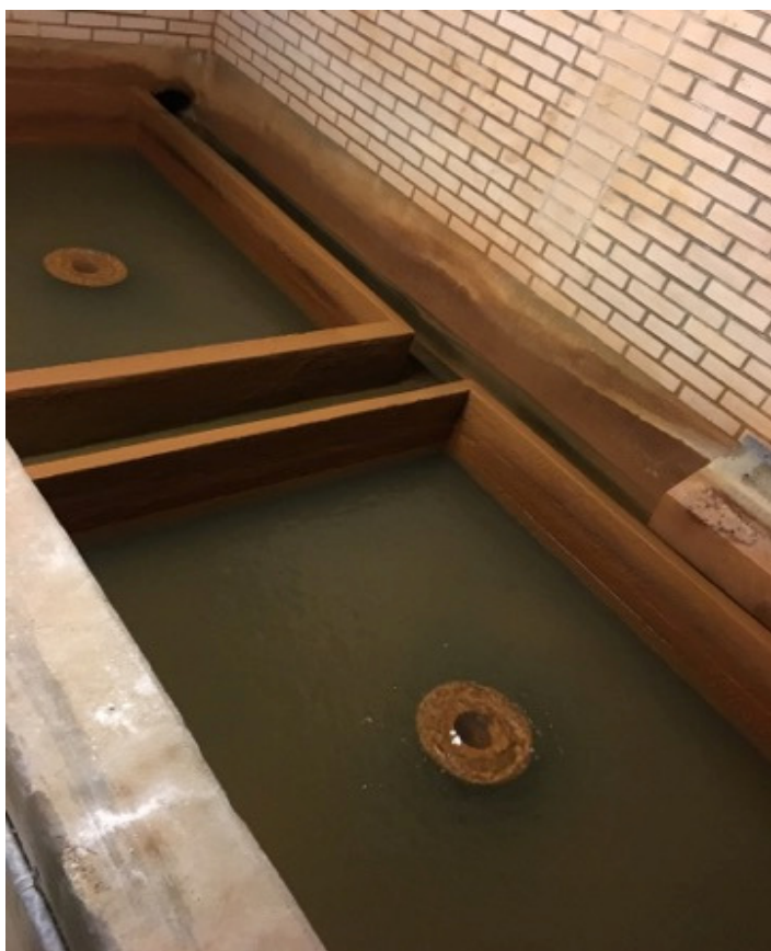
7 Åbne sandfiltre: for filtre (tv) og efterfiltre (th)
