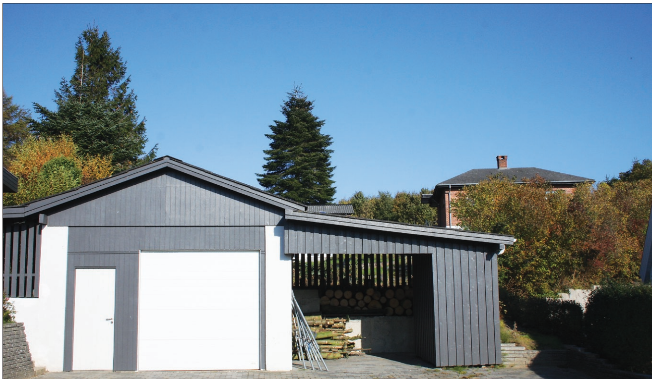
Det oprindelige vandværk beliggende på Holmelundsvej. I carport er murrester af det oprindelige vandværk beliggende på Holmelundsvej.
