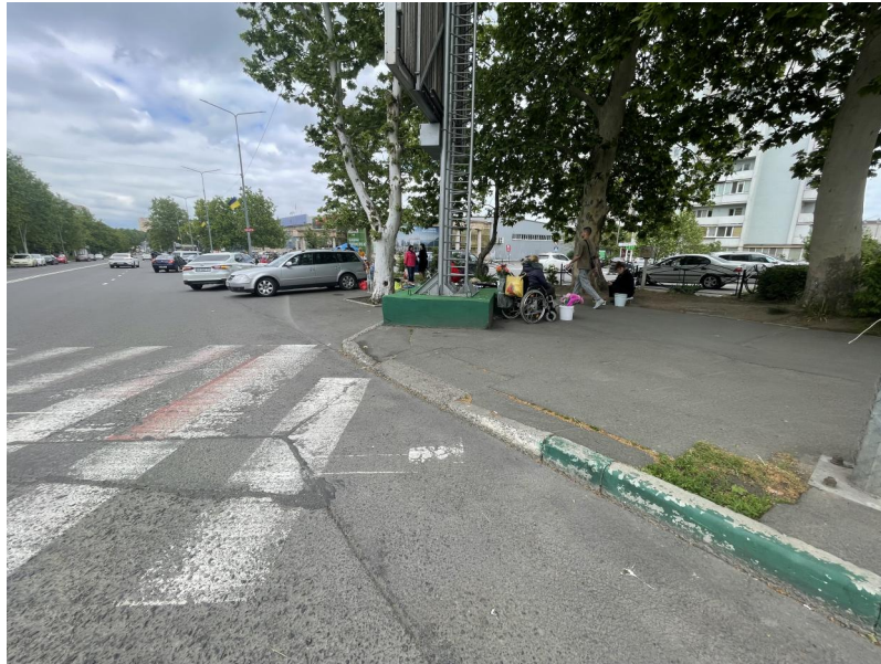
Бордюрний пандус, що частково потрапляє на заокруглення перехрестя
