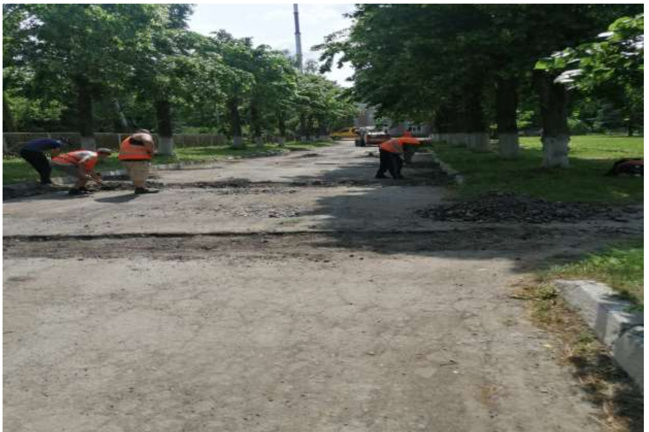
Проводився поточний ямковий ремонт асфальтного покриття по Алеї Слави.
