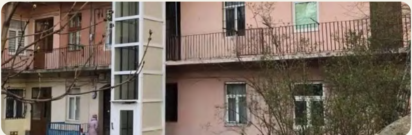
Рисунок 1.33. Приклад прибудови ліфта до галерейного будинку
