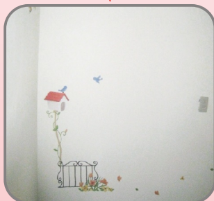
不要批土，直接上水性平光水泥漆或用壁貼裝飾。
