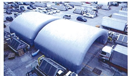
荷下ろし作業(2連棟)
