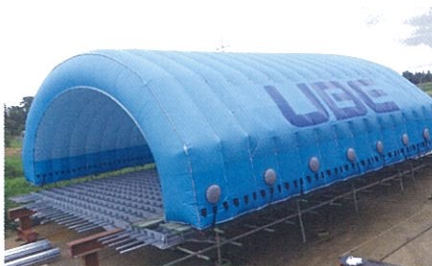
圏央道・橋梁工事
