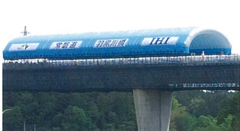
常盤道・橋梁工事(4連結)
