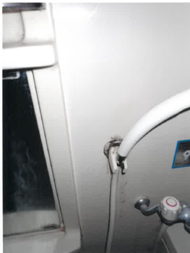
⑥浴室内壁面の損傷状況
