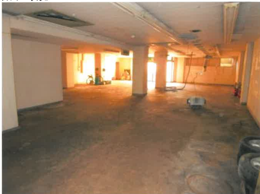
② 建物内の状況
