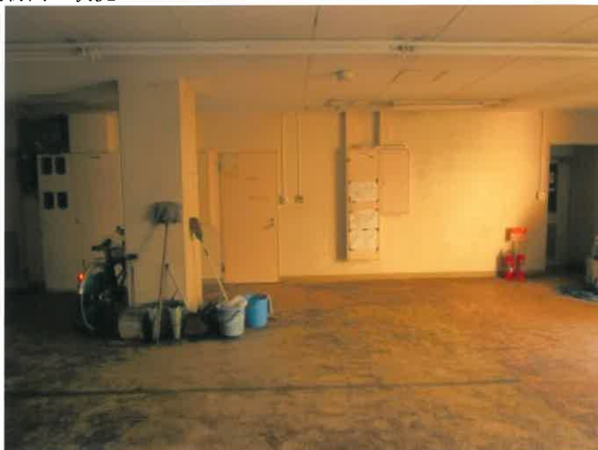
③ 建物内の状況
