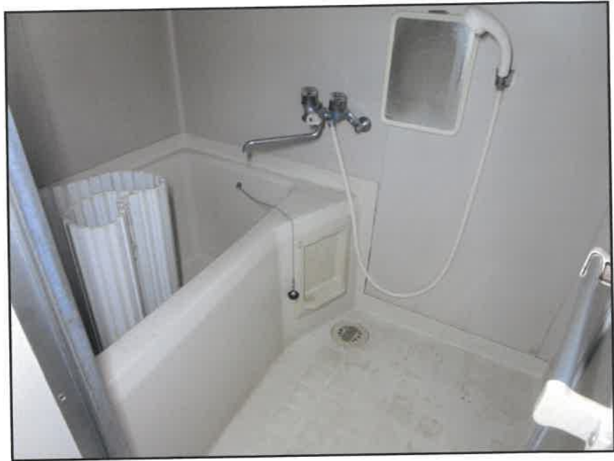
⑨ 物件3建物内の状況－201号室:浴室
