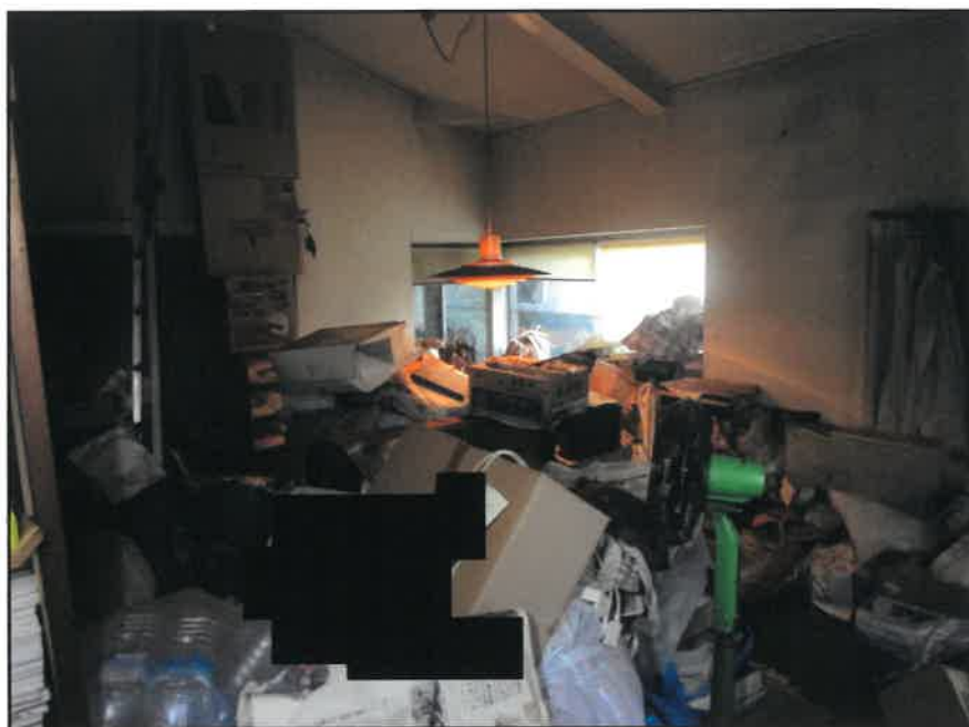
⑬ 物件4建物内の状況ーリビング(1階)
