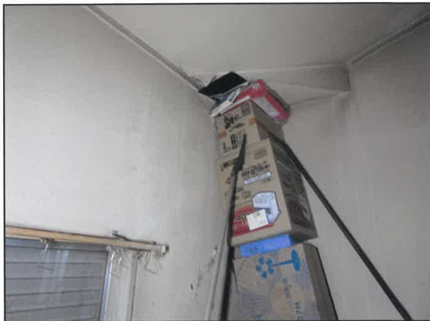
⑪ 物件4建物内の状況ーリビングの天井部分(1階)
