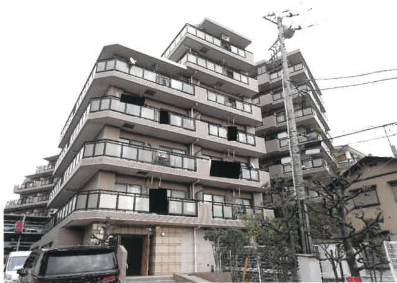
① 目的物件南西側の状況
