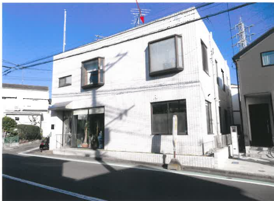
① 建物の外観（南西側から撮影）
