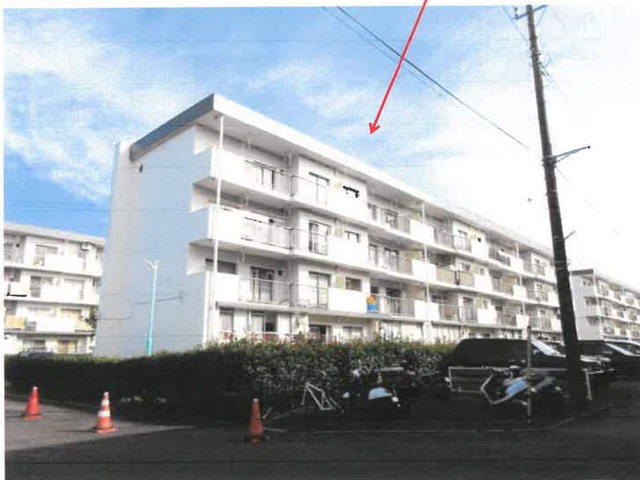
物件 1 の存する一棟の建物
