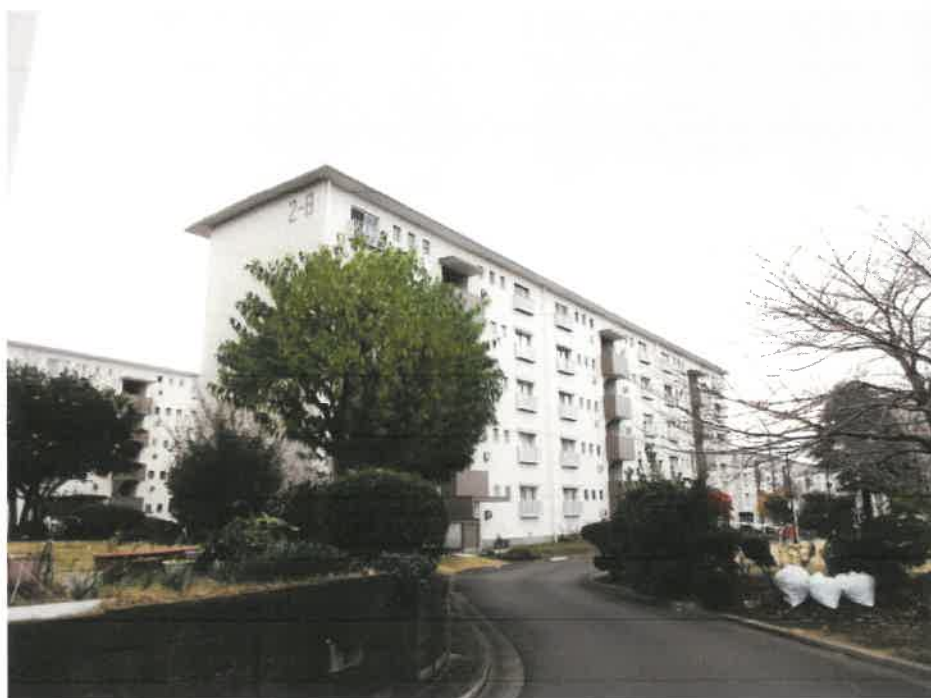
物件 1 の存する一棟の建物
