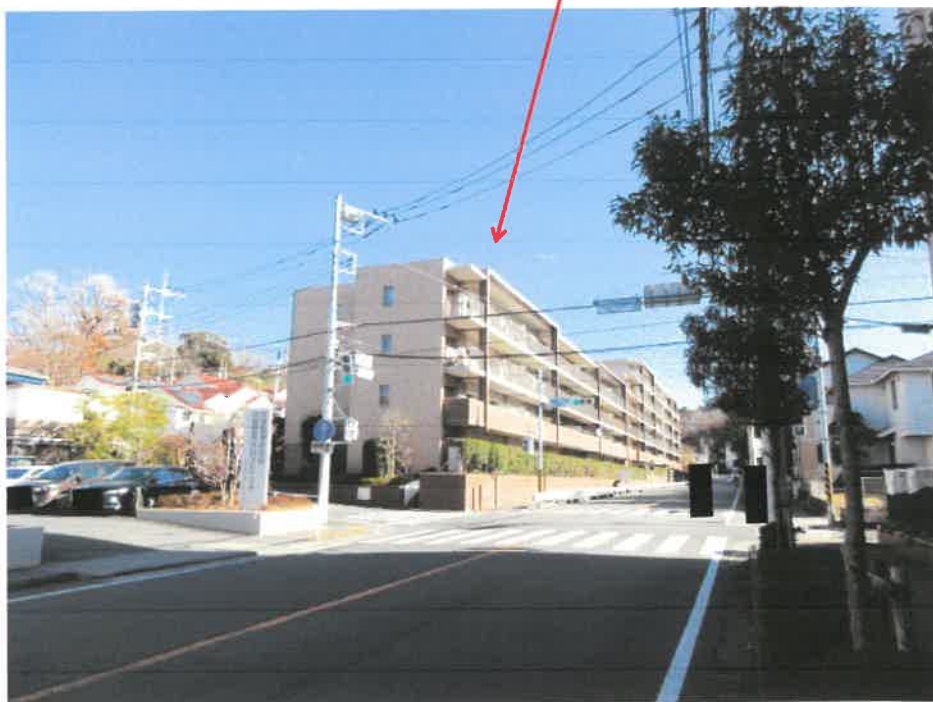
物件 1 の存する一棟の建物
