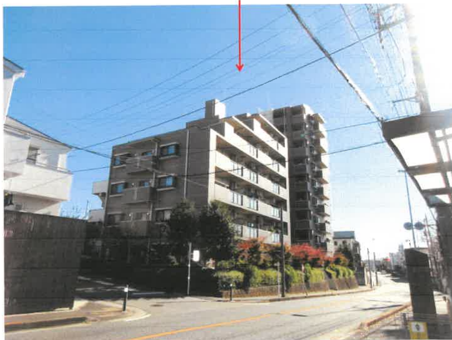
物件 1 の存する一棟の建物
