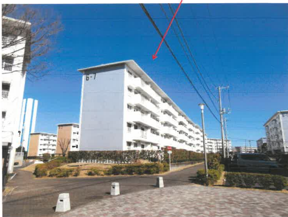
物件 1 の存する一棟の建物
