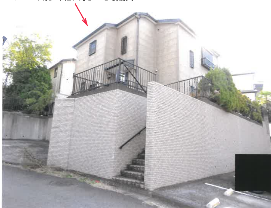
① 建物の外観（北西側から撮影）
