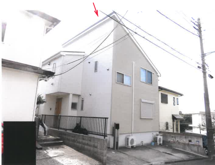
① 建物の外観（北東側から撮影）
